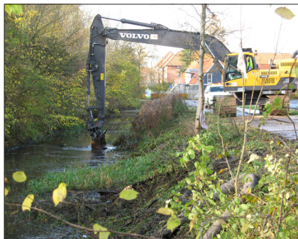
Det påbegyndte gravearbejde
