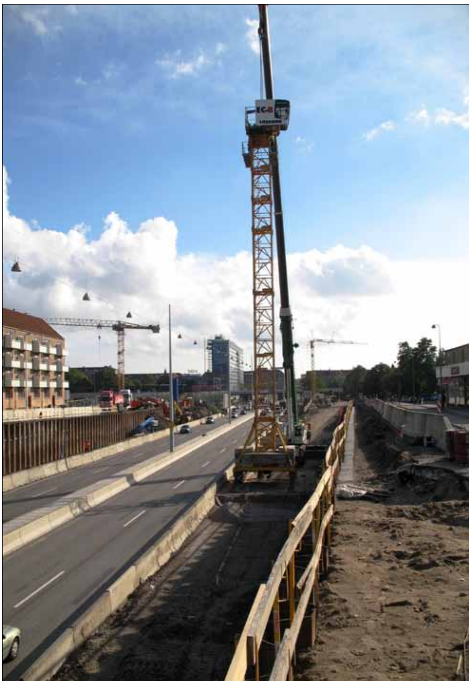
Udfletningen af Nordhavnsvej er et enormt projekt
