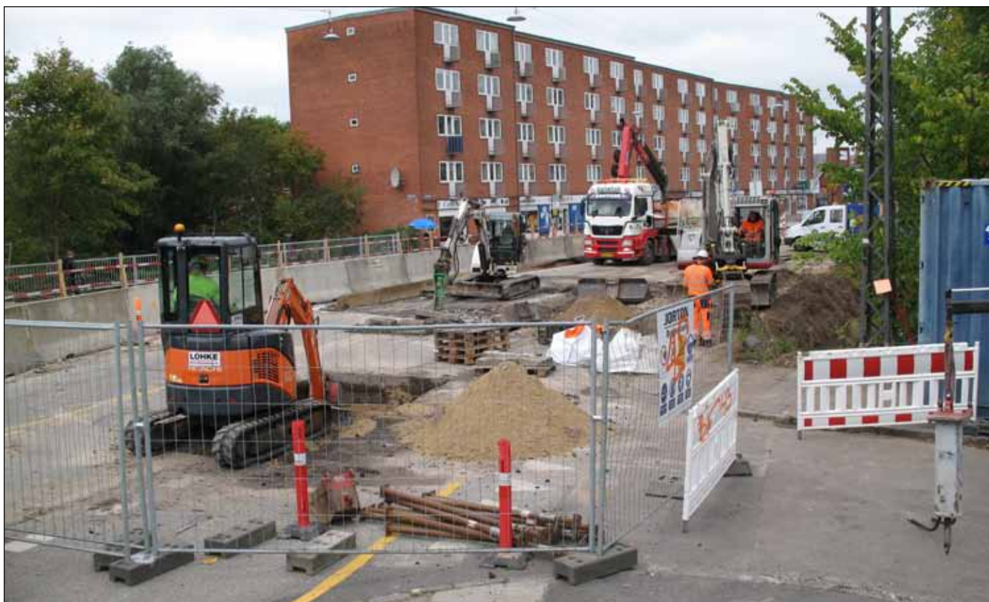
Renovering af broen på Frederiksborgvej ved Renden
