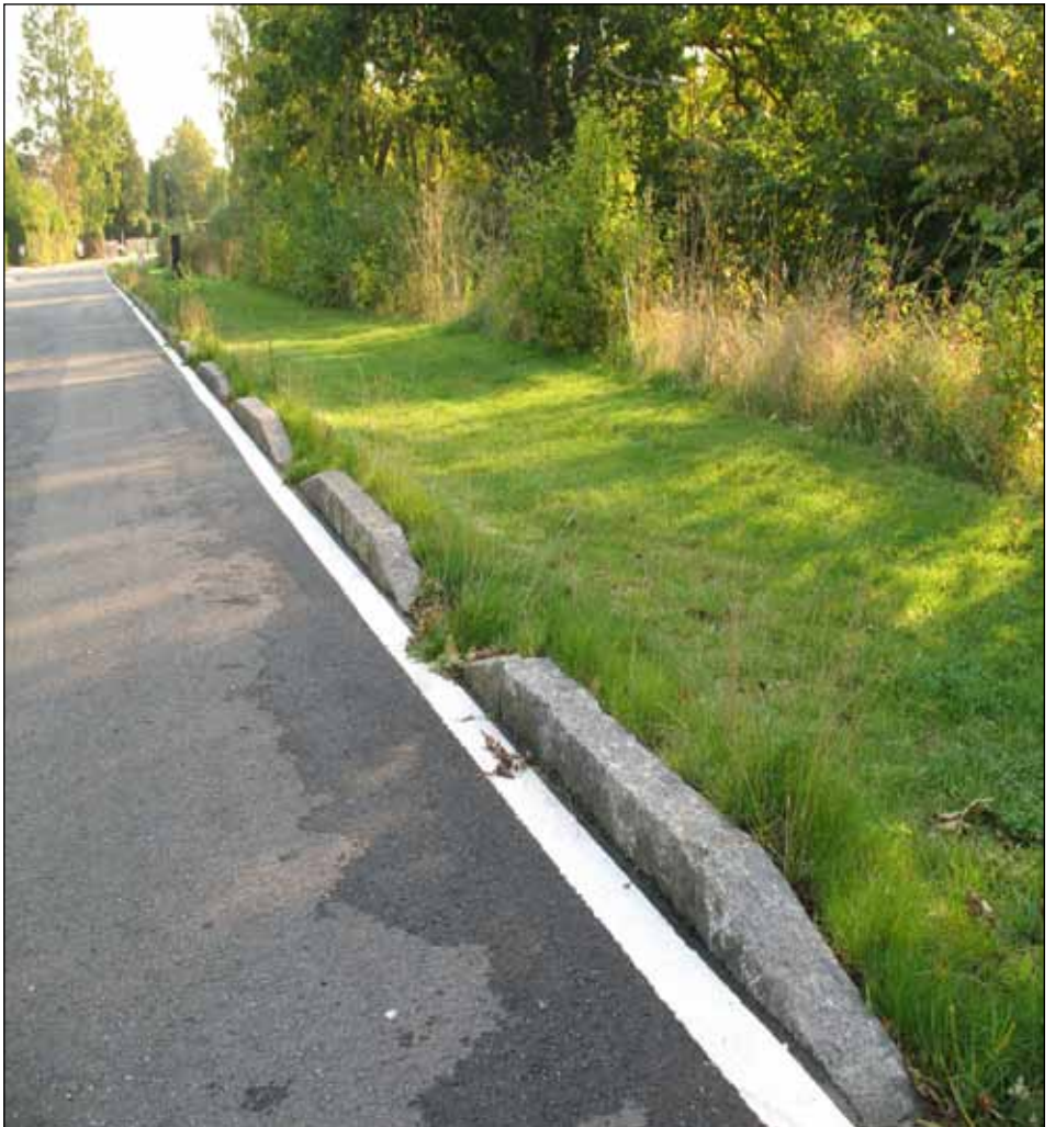
Eksempel på afvanding fra vejen ud i rabatten med forsænkede rendesten
