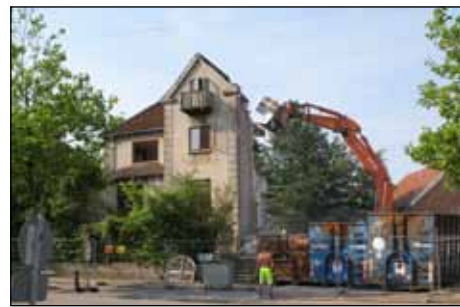
Nedrivning af den gamle villa "Elborg"
