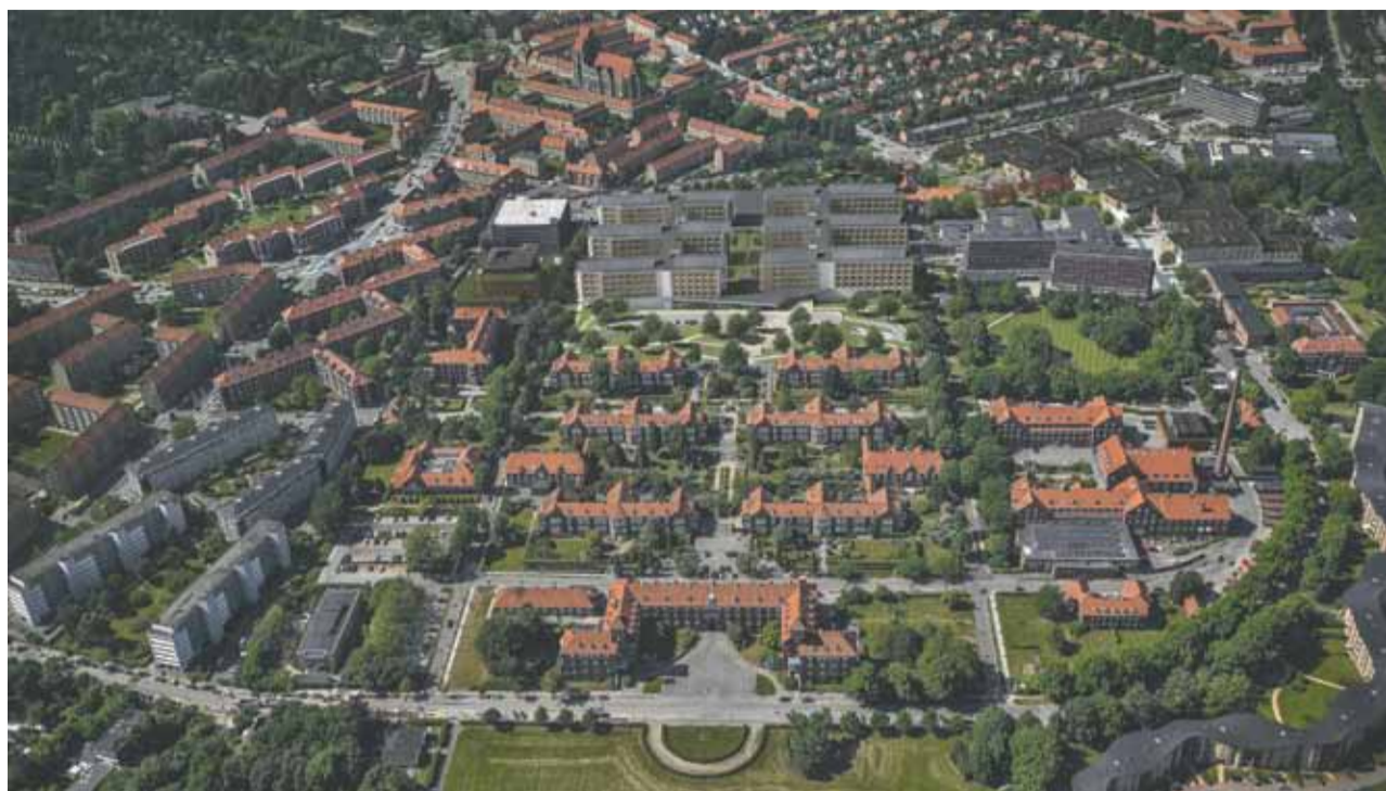
Akuthuset (midt i billedet) på Bispebjerg Hospital står færdigt op til to år før tid. Illustration: Friis & Moltke.
