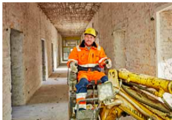
Bygning 13 husede før i tiden afdelinger på Psykiatrisk Center København. Nu skal bygningen rives ned, og murstenene genbruges i et skolebyggeri i Vanløse. Foto: Byggeriets Billedbank
