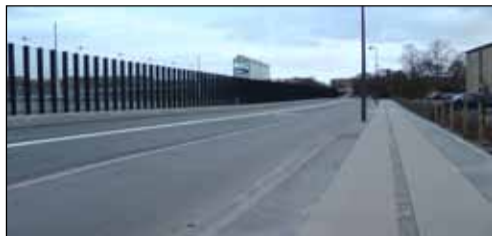
Nedkørslen til Helsingørmotorvejen fra Emdrupvej er lukket for biltrafik
